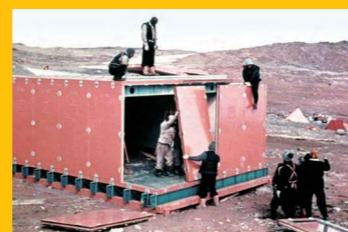
第一次隊建設風景
